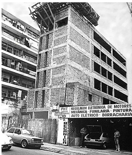
O edifício 1º de Maio em construção (1986)...
